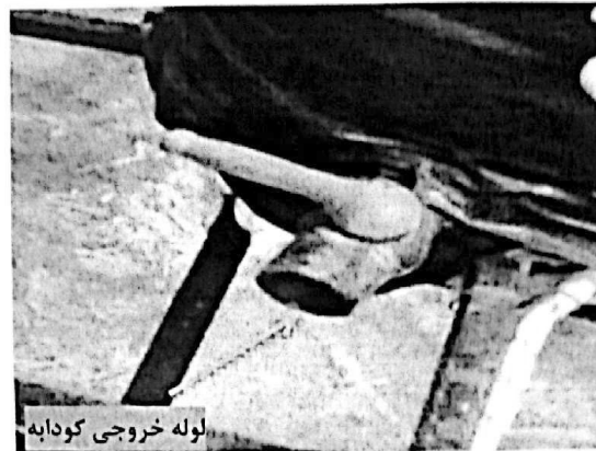
شکل ۴- لوله خروج کودابه از مخزن هضم
